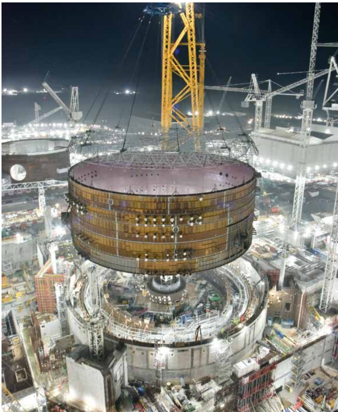
Chantier de l'EPR, Hinkley Point C
