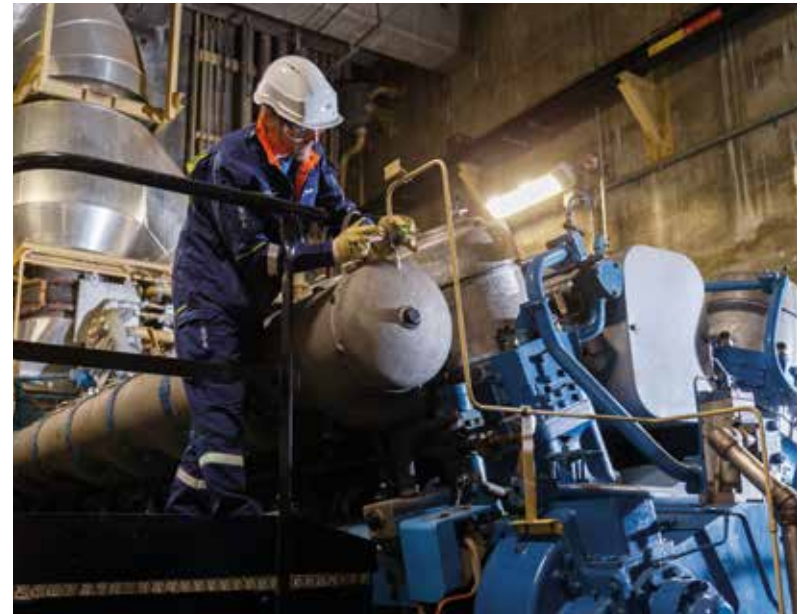
Maintenance d'un diesel
