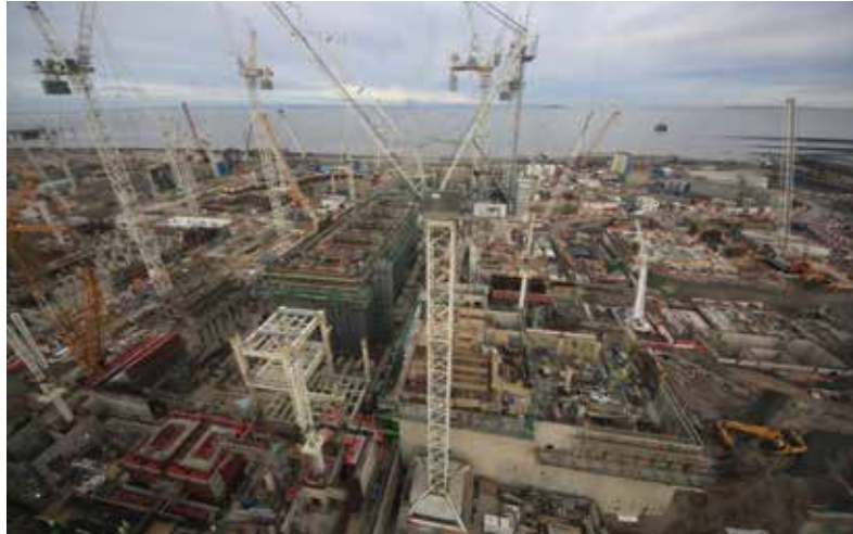
Chantier de l'EPR, Hinkley Point C
