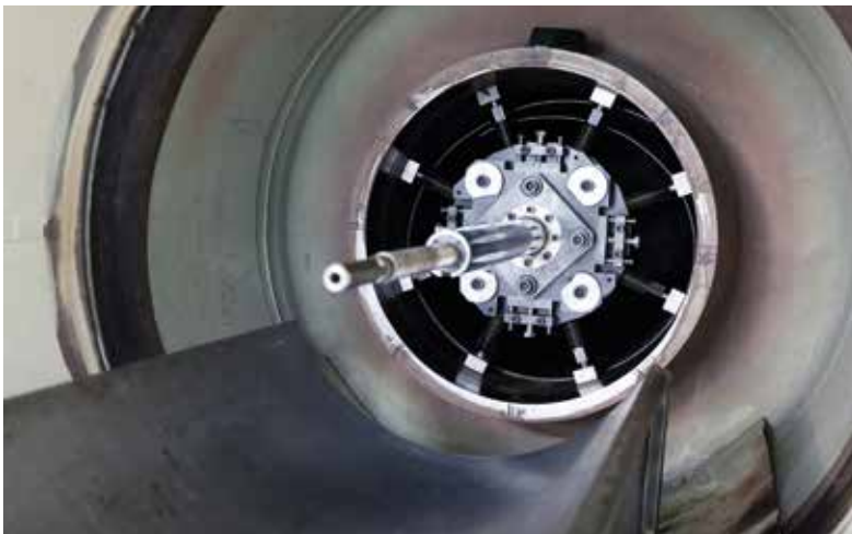
Réparation soudure du circuit secondaire principal, Flamanville 3
