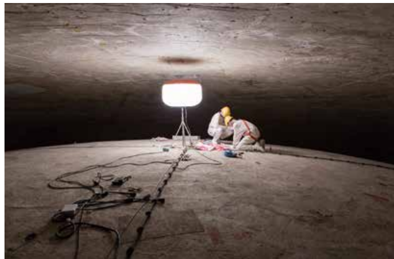
Travaux dans l'espace inter-enceinte, CNPE de Nogent
