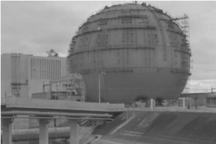
Les débuts du nucléaire à EDF. Construction de Chinon A1.
