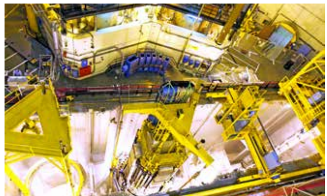
Un bâtiment réacteur
