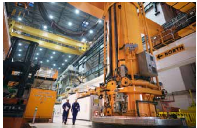
Machine de chargement de Hartlepool
