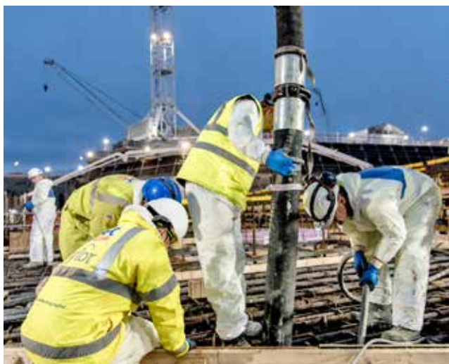
Le chantier de HPC
