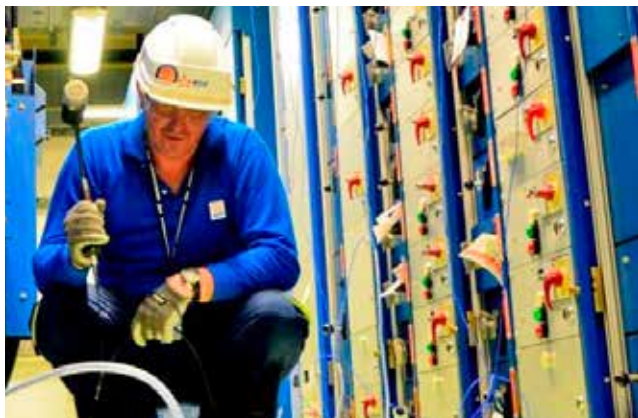
Essais sur des armoires électriques
