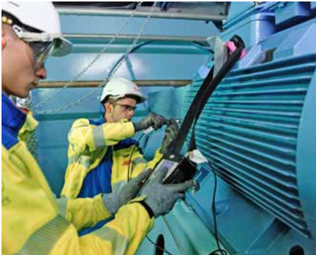
Montage des équipements
