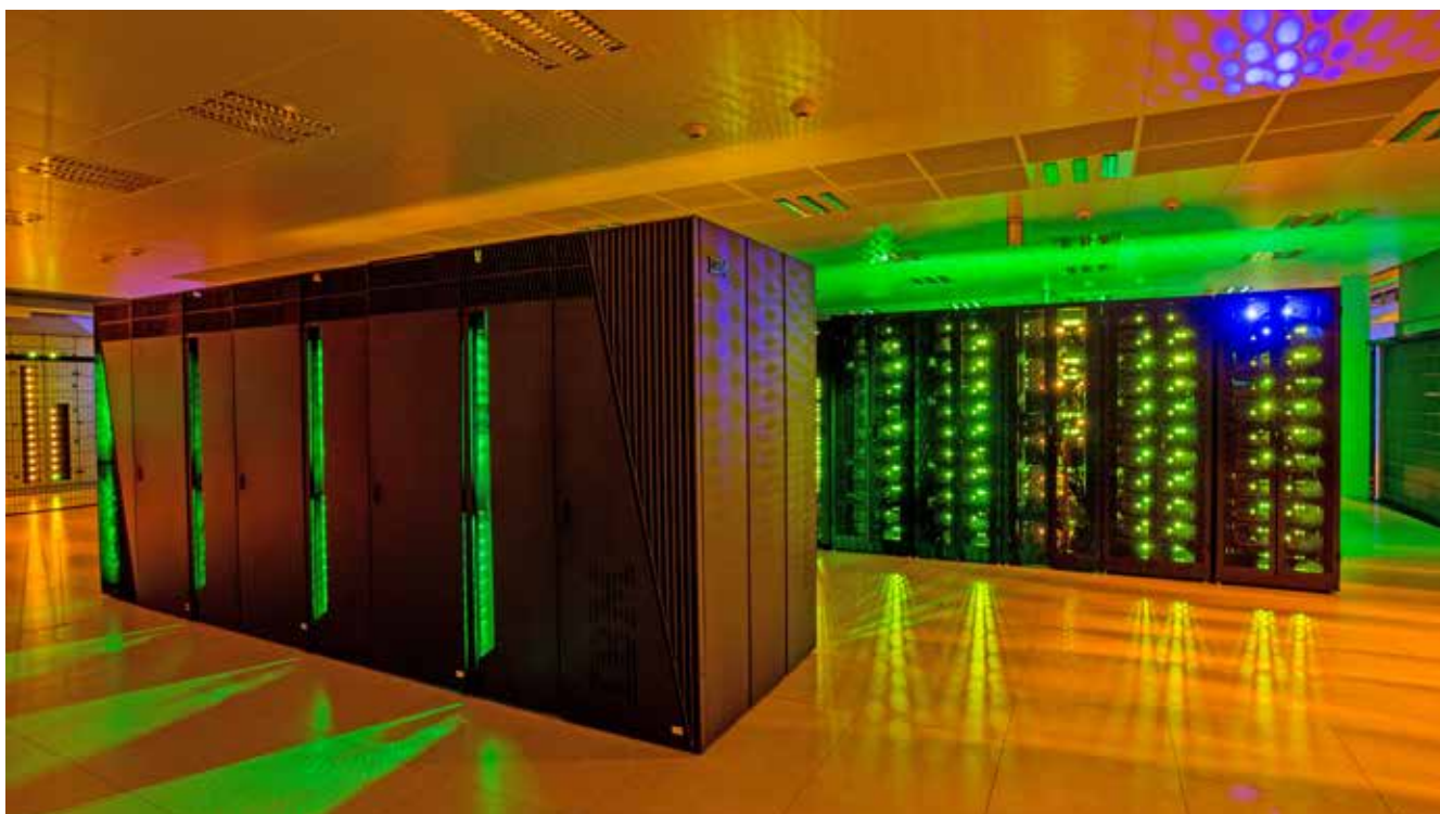
Un centre de stockage de données d'EDF
